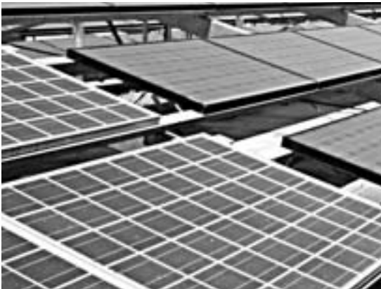
(a) 手前が多結晶シリコン、奥が単結晶シリコンの各太陽電池
