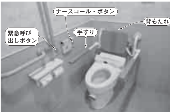
写真1 老人介護施設ではトイレ内に緊急呼び出しボタンがある
