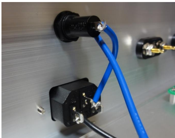
配線を穴に通して、からげてから半田付けします。
