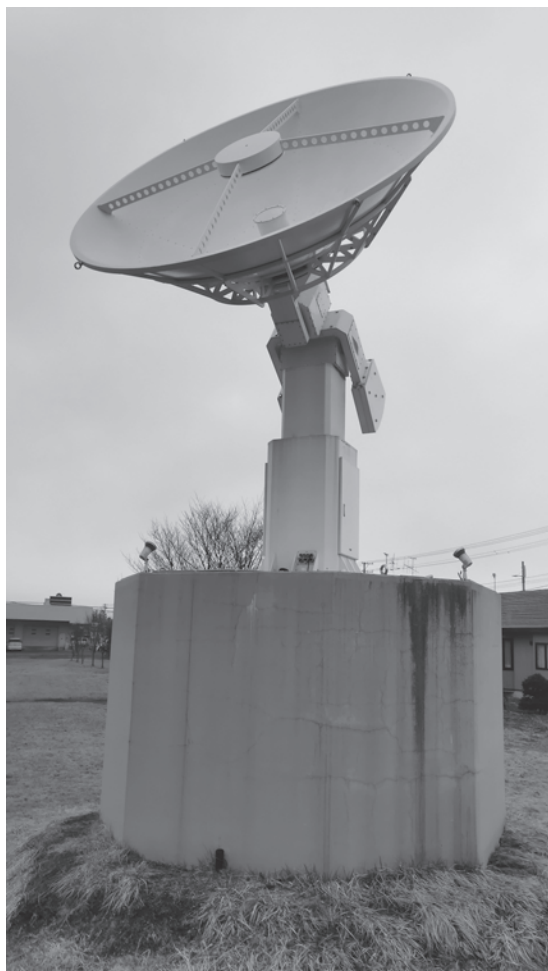
写真1 大樹町にあるパラボラ・アンテナ
