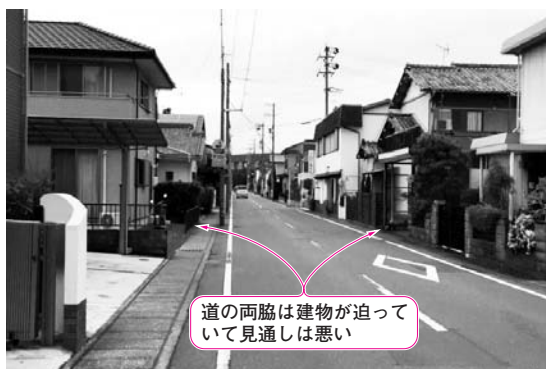
写真2 生活道路で実験 片側1車線、幅員は3m弱。両側に家が並び
