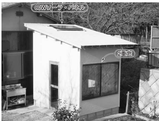
写真1 保温効果の高い省エネ工場を手作りした 壁はもちろん, 屋根, 床すべてを断熱構造とした。電気代は1月が3,760円(温室無し), 2月が6,539円(温室あり)だった。差し引き2,779円が1カ月の電気代
