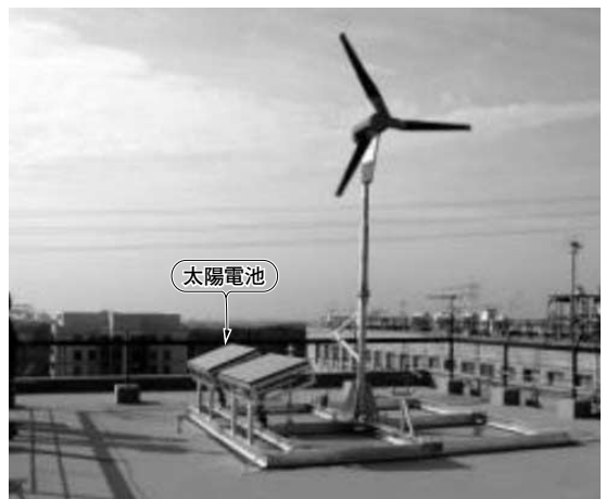
写真1 ノースパワーが施工した600W風力発電機と120W×2枚太陽電池のシステム例
