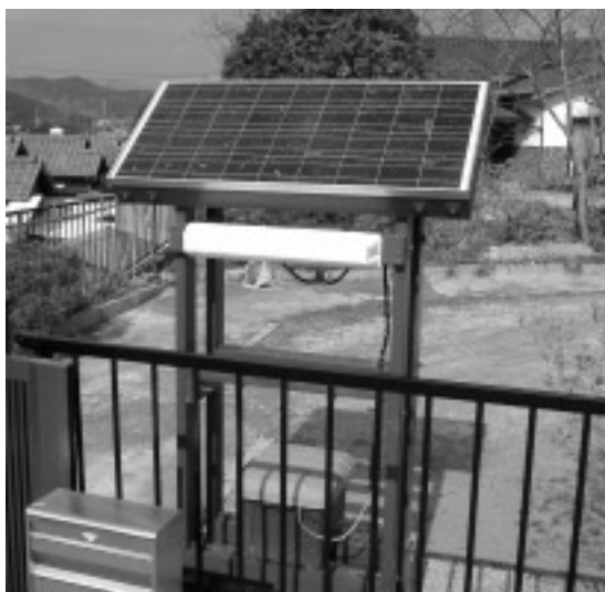
写真10-1 冬の日差しを浴びて充電中の太陽電池屋外灯
