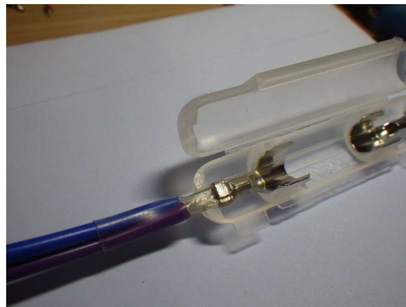
熱収縮チューブをかぶせてヒューズケースに装着
